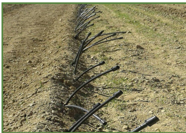
شکل ۱۱- لوله‌های ۱۶ آمادۀ برای اتصال به نوارهای تیپ (مدفون‌شده در زیر خاک)
