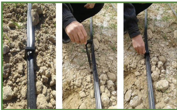
شکل ۱۵- مهار نوارهای آبیاری با گیره در روی زمین
