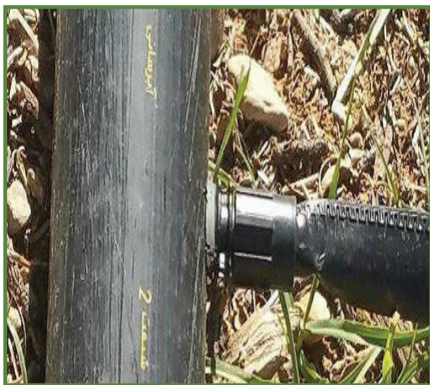
شکل ۱۳- نحوه اتصال مستقیم نوارهای تیپ به لوله آبده
