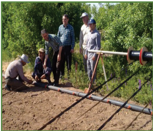
شکل ۲۱- نصب دستی نوار آبیاری قطره‌ای
