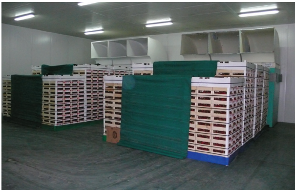
شکل ۱۶- نمایی از سیستم سردکردن جعبه های سیب (به مسدود شدن انتهای جعبه های میوه و کانال مکش هوا در بالای
