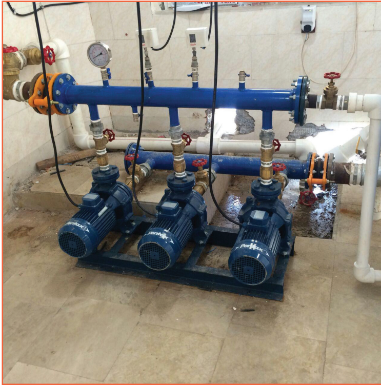
شکل ۱۰- ایستگاه پمپاژ در سامانه‌های سنتریپوت و لینیر
