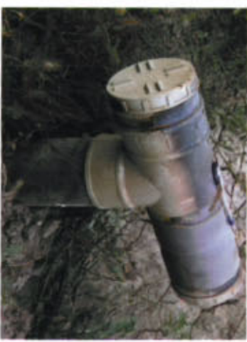
شکل ۵ خروجی لوله از زمین انشعاب دو طرفه و درپوش
