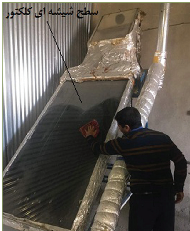
شکل ۱۰- تمیز کردن سطح شیشه‌ای واحد جمع‌کننده
