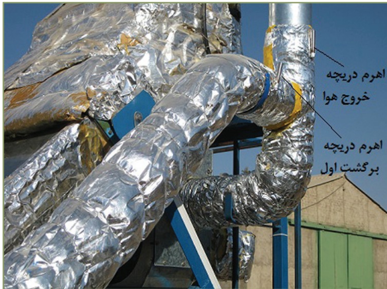
شکل ۱۴- دریچه‌های خروج هوا و برگشت هوای اول
