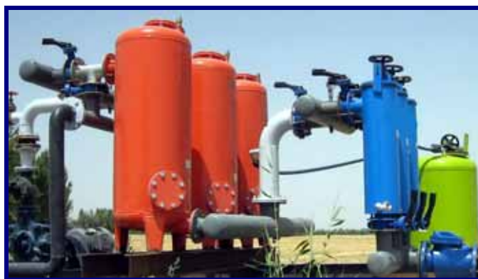
شکل ۴- سیستم کنترل مرکزی آبیاری قطره‌ای
