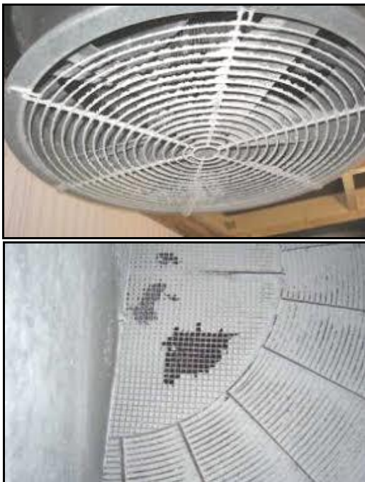
شکل ۳ - تجمع ذرات کلروپروفام روی اجزای دمنده سیستم تهویه انبار
