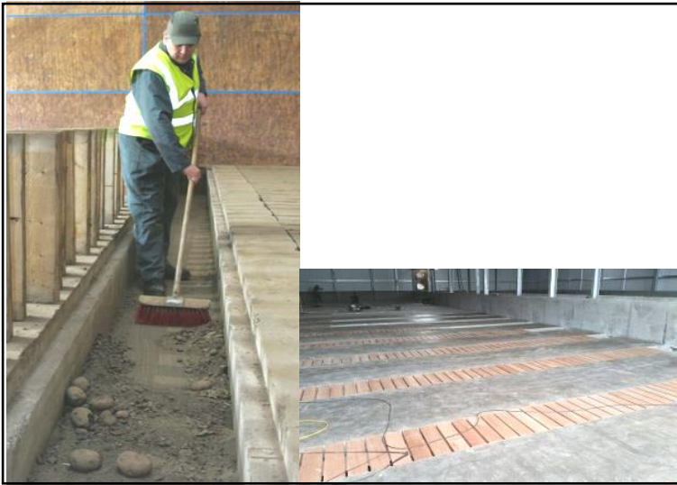
شکل ۷- بازبینی و تمیز کردن کانال‌های هوادهی در انبار سیب‌زمینی
