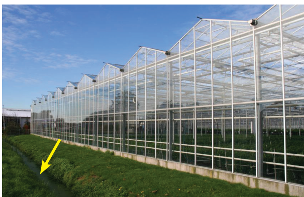
شکل ۵۰: شیوه جمع‌آوری و دفع آب ناشی از بارندگی‌های فصلی پیرامون گلخانه‌ها
