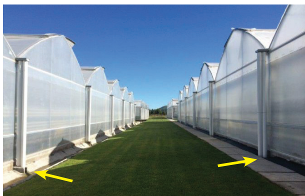
شکل ۴۷: شیوه جمع‌آوری و دفع آب ناشی از بارندگی‌های فصلی پیرامون گلخانه‌ها
