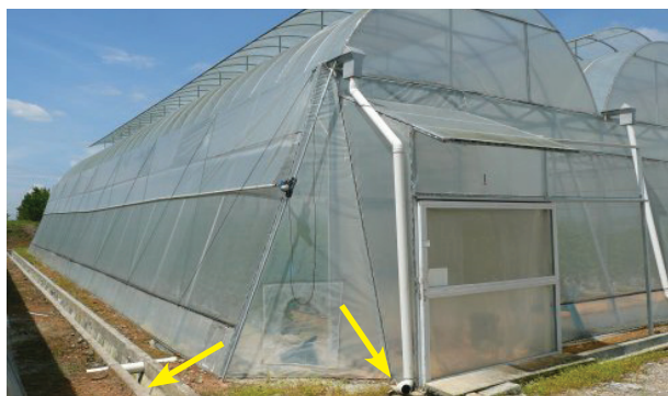
شکل ۴۸: شیوه جمع‌آوری و دفع آب ناشی از بارندگی‌های فصلی پیرامون گلخانه‌ها
