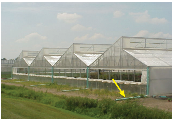
شکل ۴۹: شیوه جمع‌آوری و دفع آب ناشی از بارندگی‌های فصلی پیرامون گلخانه‌ها
