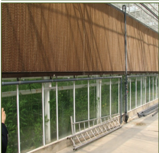
شکل ۲۳: نمونه‌یی از سیستم سرمایش تبخیری پد- فن نصب شده در گلخانه‌ها (بالا) و جریان چرخش آب در سیستم سرمایش تبخیری پد - فن نصب شده در گلخانه‌ها (پایین)
