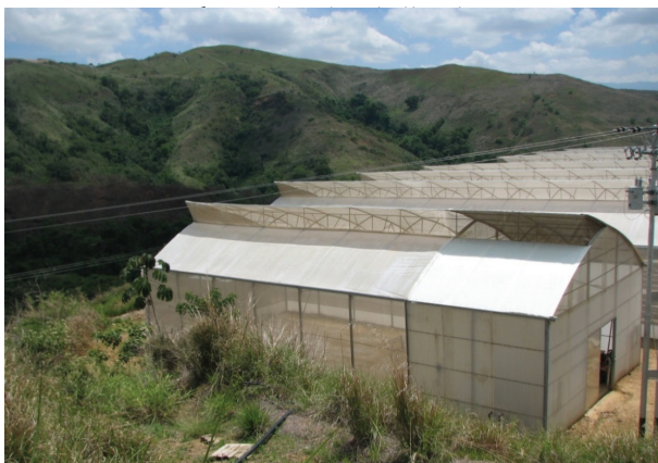
شکل ۴۱: چگونگی سایه‌اندازی گلخانه‌ها بر یکدیگر و ضرورت
