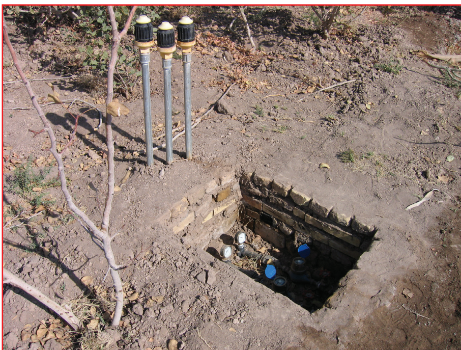
شکل ۶- نمونه ای از نصب کنتور حجمی، فشارسنج و شیر تخلیه هوا در آبیاری قطره ای زیرسطحی
