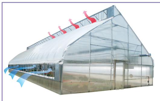
شکل ۱۷- دریچه‌های جانبی و سقفی گلخانه
