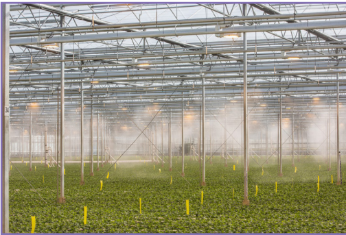
شکل ۴۸- سیستم مه پاش گلخانه‌ای
