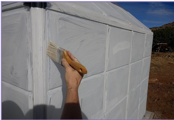
شکل ۱۱- سایه‌دهی پوشش گلخانه با رنگ آمیزی به روش دستی
