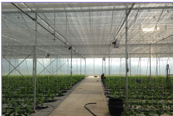
شکل ۴- نصب توری سایه‌انداز داخل گلخانه
