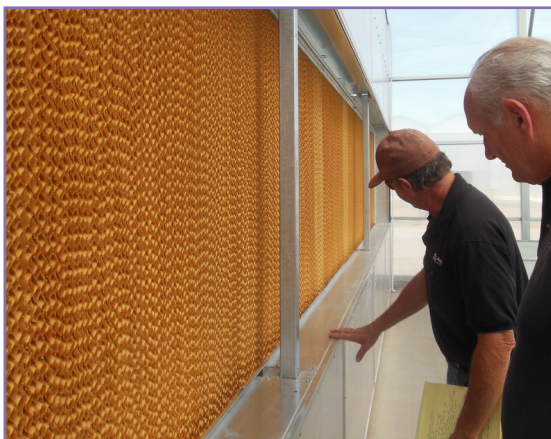
شکل ۴۰- نصب پد در دیواره طولی گلخانه
