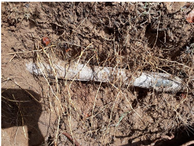
تصویر ۱۱- محل قرارگیری لوله آبدار در پروفیل خاک (ابداعی شرکت نوآبیاران بوستان مهر)
