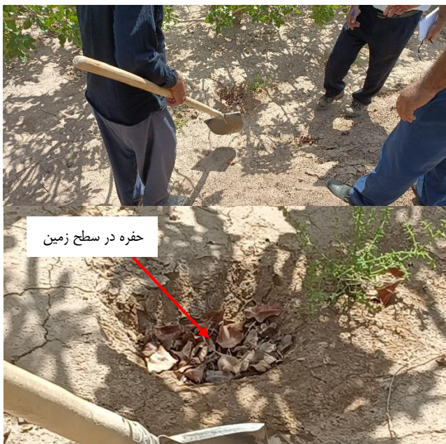
تصویر ۱۸- آثار به جا مانده از ایجاد حفره در سطح زمین در یکی از باغ‌های تجهیز شده به سامانه زیرسطحی کم فشار در منطقه رفسنجان
