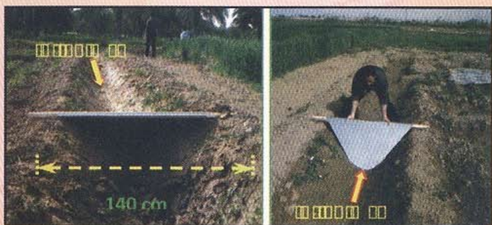
شکل ۴- روش خواباندن و استقرار آببند به صورت مایل در برابر جریان آب در نهر (مرحله اول نصب)
