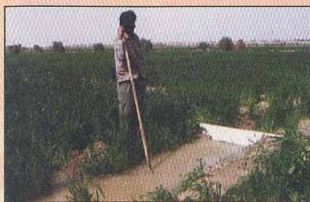
شکل ۶- بالا آمدن آب در پشت آب‌بند و هدایت آن به کرت (مرحله سوم نصب)
