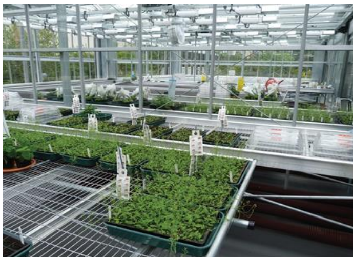
شکل ۶. نیمکت‌های فلزی مشبک با سیستم گرمایش از کف که توسط لوله‌های پره‌دار در زیر آنها نصب شده است (عکس با اجازه از آزمایشگاه ساینزبری، دانشگاه کمبریج، بریتانیا)
