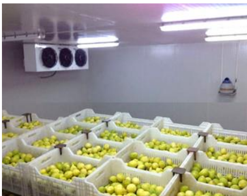
شکل ۳۸- خنک کردن جعبه‌های انجیر با هوای سرد تحت فشار (آی‌ای‌سی لینگ، ۲۰۲۱).
