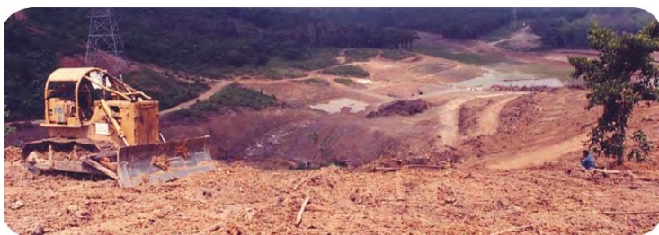
شکل ۱۶- پاکسازی پوشش گیاهی موجود برای ایجاد بستر تالاب مصنوعی
