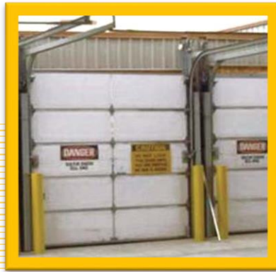
شکل ۳- محفظه های گازدهی برای کنترل آفات انباری خرما
