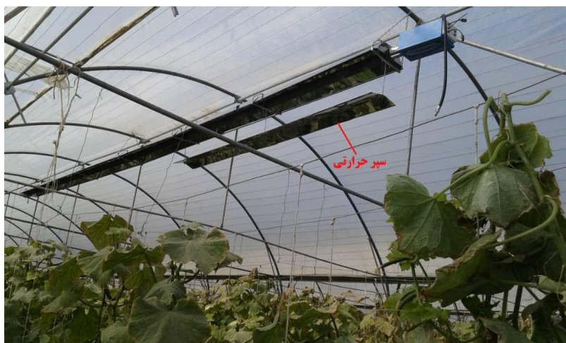
شکل ۱۵- نصب سیلر حرارتی در ابتدای لوله سامانه گرمایش تابشی
