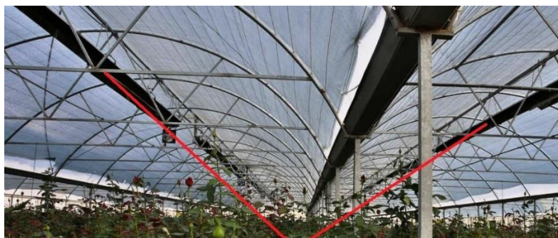
دو ردیف سامانه گرمایش تابشی با فاصله ۱۰ متر از یکدیگر
