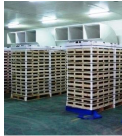
شکل ۱۱- پیش‌سرمایش با هوای سرد اجباری
