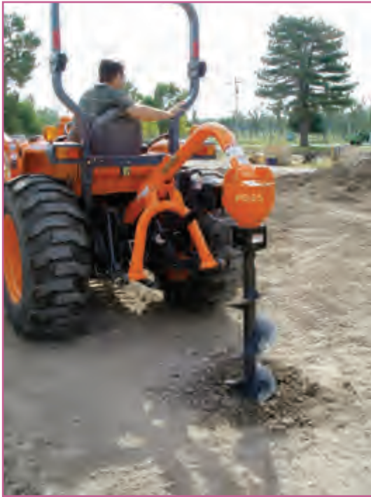
شکل ۱۵- حفر چاله توسط گودال‌کن پشت تراکتوری
