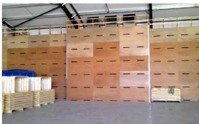
شکل ۲۲- دیواره‌های مکش تعبیه شده در انبار سیب زمینی برای تضمین تهویه لایه‌ای کل محصول
