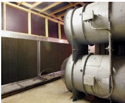
شکل ۲۸- نمایی از یک دستگاه رطوبت‌زن همراه با صفحات خنک‌کننده هوای تازه. منبع: (امراگی و همکاران، ۲۰۲۱)
