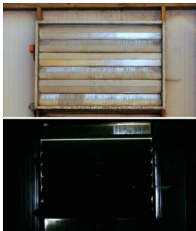
شکل ۲۹- حتی اگر درزبندی دریچه‌های انبار در ظاهر مناسب باشد (بالا)، بازدید آنها در روز و هنگامی که انبار تاریک است شکاف‌ها و درزها را به خوبی آشکار می‌کند (پایین منبع: (مولفین)
