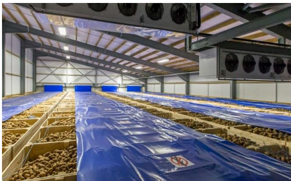
شکل ۲۰- مکش جانبی، گزینه‌ای مفید در طراحی سامانه‌های تهویه جابه‌جایی مثبت در انبارهای سیب‌زمینی است.
