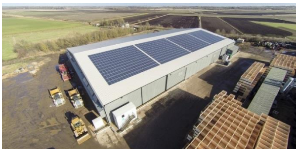
شکل ۳۱- استفاده از صفحه‌های خورشیدی برای تأمین بخشی از برق مصرفی انبار سیب زمینی منبع: ( https://www.southeastfarmer.net/ )
