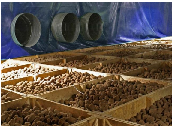
شکل ۱۸- پرده جدا کننده فضا در انبار با سامانه تهویه روباز منبع: (پرینگل، ۱۹۹۲)
