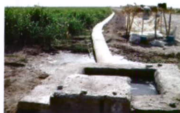
شکل ۱: انتقال آب در انهار سنتی و هیدروفلوم
