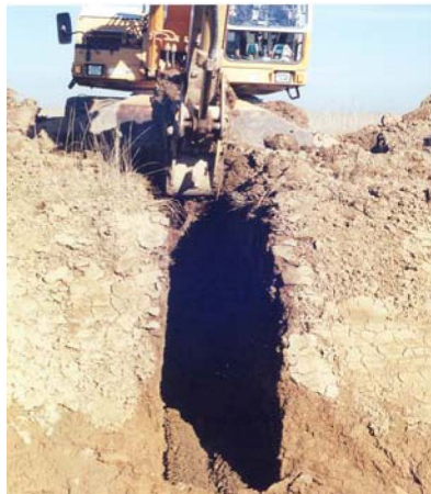
شکل ۳- حفر ترانشه زهکش زیرزمینی در مزرعه آزمایشی آونجان فارس
