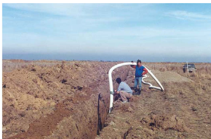
شکل ۲- عملیات لوله‌گذاری در مزرعه آزمایشی
