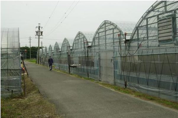
شکل ۱۶- گلخانه پوشیده شده با پلاستیک جذب UV (آزادشهرکی و همکاران، ۱۴۰۰)
