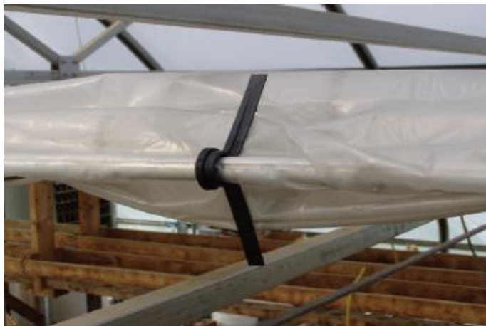
شکل ۸- نمونه‌ای از ابزار جمع کردن پرده کشویی پشت لوله لبه انتهایی هنگام باز بودن پرده
