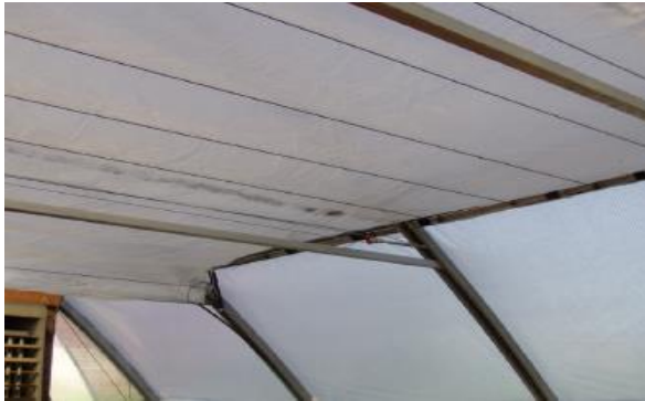
شکل ۷- سیستم پرده‌ای کشویی و سیم‌های پلی‌استر نگهدارنده آن
