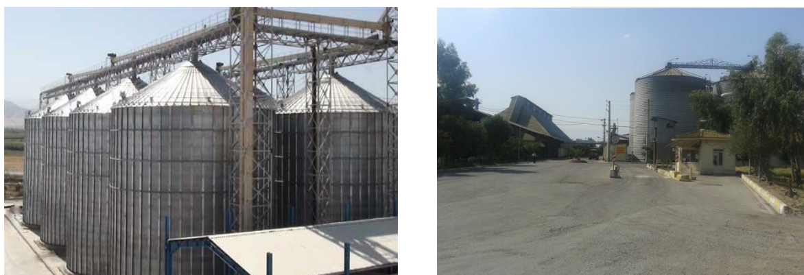
شکل ۱۲۲- سیلوهای فلزی برای نگهداری کلزا
