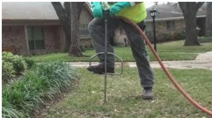
شکل ۲- استفاده از نیروی پا برای فروکردن نازل در خاک
