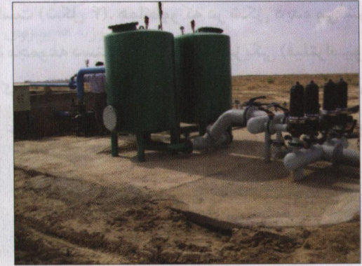
شکل ۵- نمونه هایی از ایستگاه پمپاژ و دستگاههای تصفیه فیزیکی آب ( فیلتراسیون)
