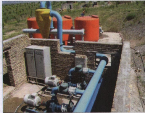
شکل ۵- نمونه هایی از ایستگاه پمپاژ و دستگاههای تصفیه فیزیکی آب ( فیلتراسیون)
