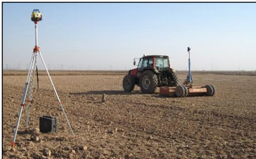
شکل ۱۶- تسطیح اساسی زمین با لولر لیزری
