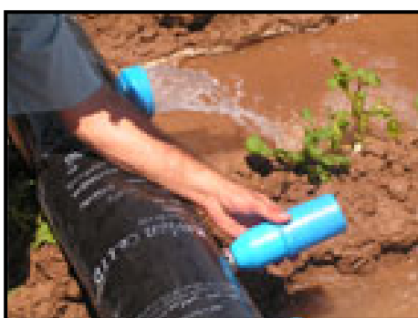
شکل ۱۵- نحوه پانچ کردن دریچه‌ها
