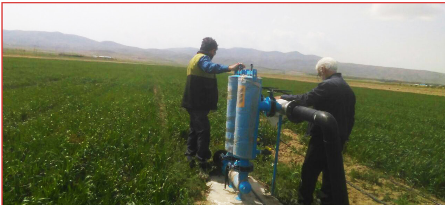
شکل ۸- فیلتر توری مورد استفاده در آبیاری قطره‌ای
