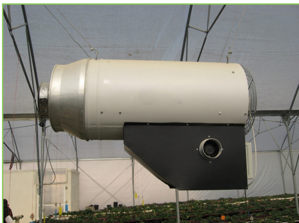
شکل ۲۷- کاربرد دمنده هوای گرم در گرمایش گلخانه تولید توت‌فرنگی در استان اصفهان
