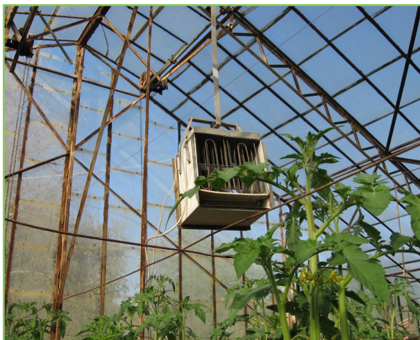
شکل ۳۱- کاربرد گرم‌کن‌های برقی در گرمایش گلخانه تولید گوجه‌فرنگی در منطقه کمر ترکیه
