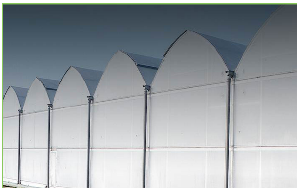
شکل ۱۸- گلخانه گنبدی با پوشش دولایه
