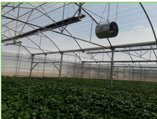
شکل ۲۹- سیستم گرمایش تابشی در گلخانه توت‌فرنگی همدان
