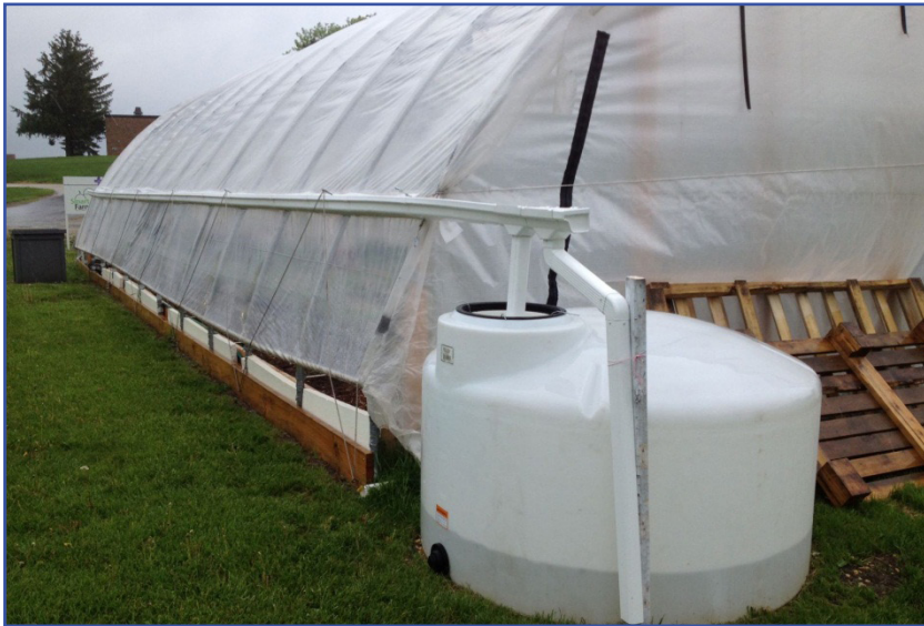
شکل ۱۲- جمع آوری آب باران از سقف گلخانه
