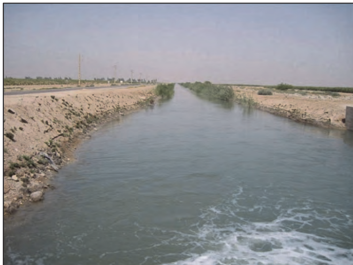
شکل ۱۶- یکی از نه‌رهای داخلی کشت و صنعت نیشکر جهت انتقال بخشی از زه‌آب زیرزمینی تولید شده
