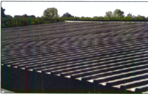
شکل ۱۴ - صفحات خورشیدی بر روی سقف خشک‌کن گردو
