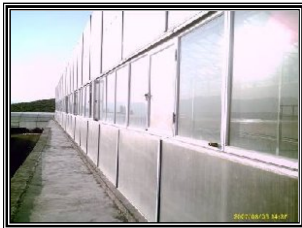
شکل ۲: استفاده از شیشه و پلی کربنات در گلخانه.
