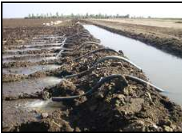
شکل ۷ و ۸ - استفاده از سیفون جهت انتقال آب از نهر به فارو
