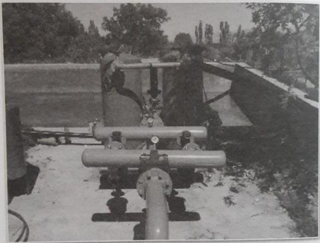
شکل ۷- استفاده از فشارسنج جهت کنترل سیستم آبیاری قطره ای
