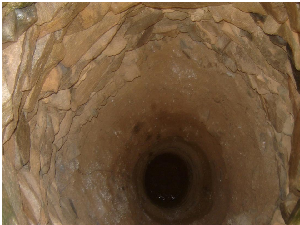
شکل ۳- سنگ چینی داخل میله قنات
