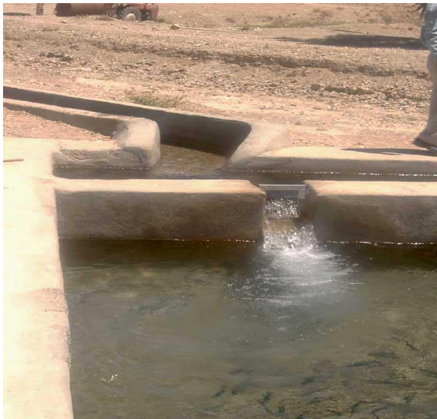
شکل ۱۳- احداث حوضچه پرورش ماهی در مسیر آب قنات
