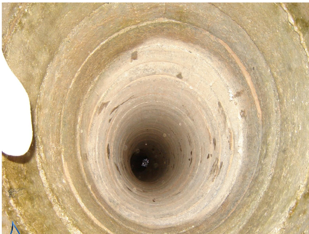
شکل ۱۱- میله طوقه چینی شده
