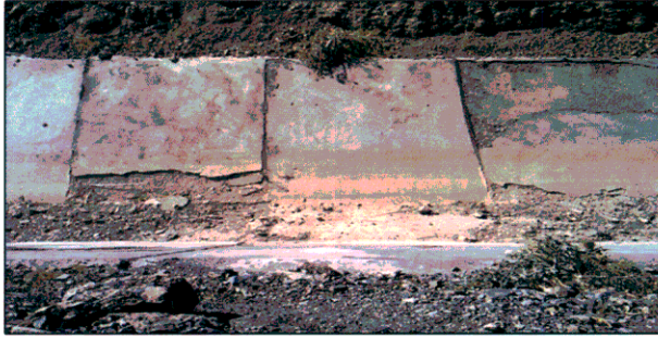
شکل ۷- نمونه‌ای از پوسته‌ای شدن و تخریب پوشش بتنی در اثر ذوب و یخبندان
