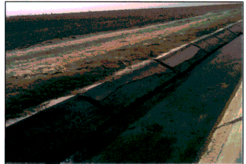
شکل ۱- ترک خوردگی پوشش بتنی در کانال‌های آبیاری
