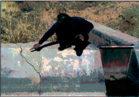
شکل ۱- ترک خوردگی پوشش بتنی در کانال‌های آبیاری
