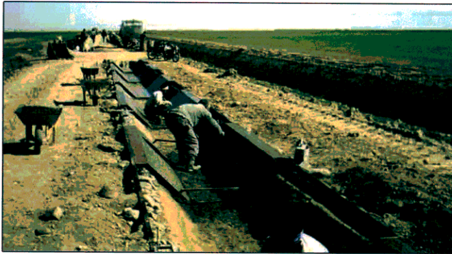
شکل ۱۱- بتن ریزی در قسمت جانبی مقطع کانال بدون ویبره‌زنی
