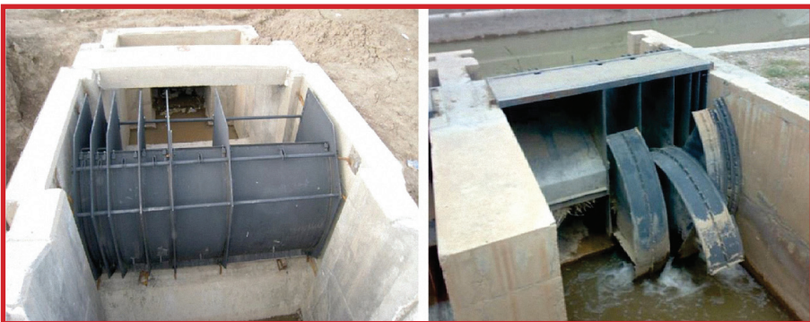
شکل ۱۰- یک نمونه دریچه مدول نیروپیک مورد استفاده در شبکه های آبیاری
