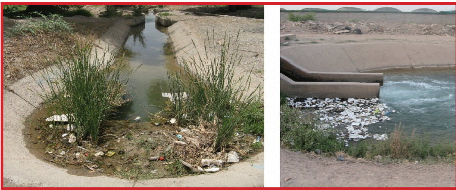
شکل ۹- ورود انواع آشغال شناور به کانال های آبیاری
