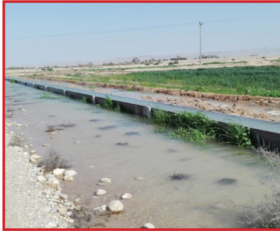
شکل ۴- استفاده اشتباه از کانالت
