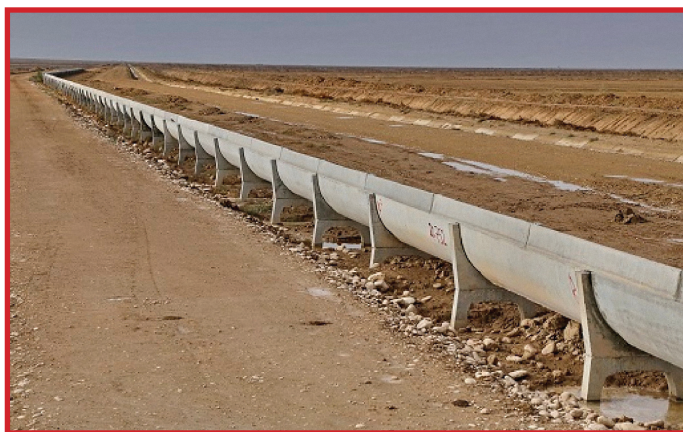
شکل ۱۵- کانالت نصب شده
